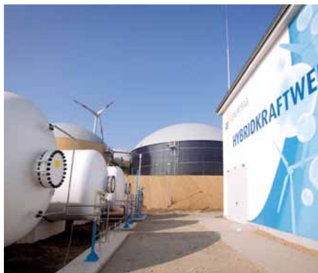
Hybridkraftwerk von ENERTRAG in Prenzlau
